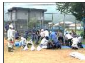
〔校庭での土嚢づくりの様子〕
